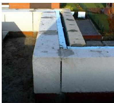
Figure 4.10 Des éléments isolants peuvent, suivant la règle de base 2, être intercalés pour assurer la coupure thermique, par exemple à l'endroit d'un acrotère (à gauche) et à l'endroit d'un appui de fondation (à droite).
