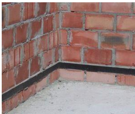
Figure 4.10 Des éléments isolants peuvent, suivant la règle de base 2, être intercalés pour assurer la coupure thermique, par exemple à l'endroit d'un acrotère (à gauche) et à l'endroit d'un appui de fondation (à droite).
