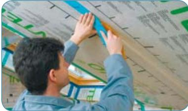
Les lés du film étanche à l'air (polyéthylène par exemple) sont collés au moyen d'une bande adhésive. Cette même bande est utilisée pour obturerer les trous résultant de l'agrafage.
