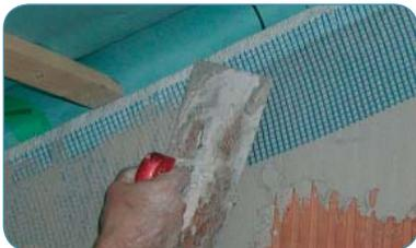
Des membranes munies de filet permettent la continuité entre le plafonnage et le film pare-vapeur.
